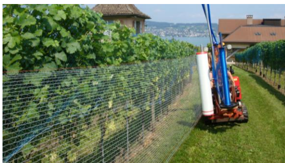
Maschinelles Verlegen von Überzeilen- und Seitennetz.
